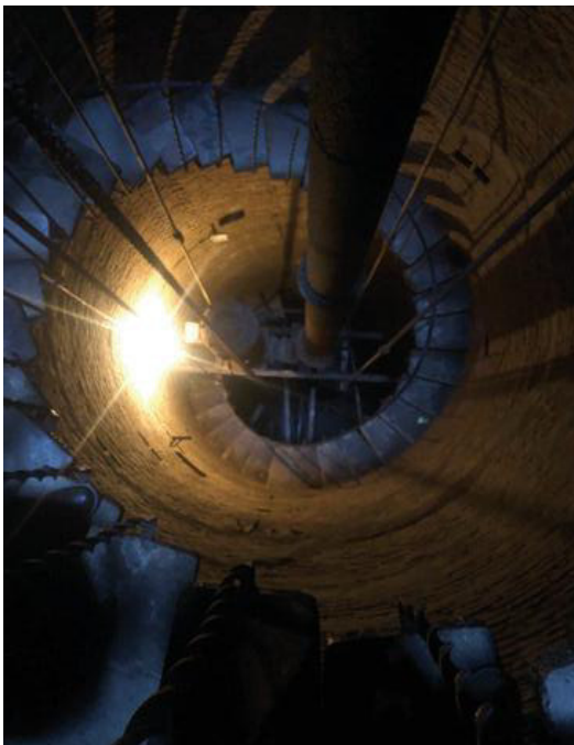
Fotografía interior del pozo desde arriba hacia abajo
