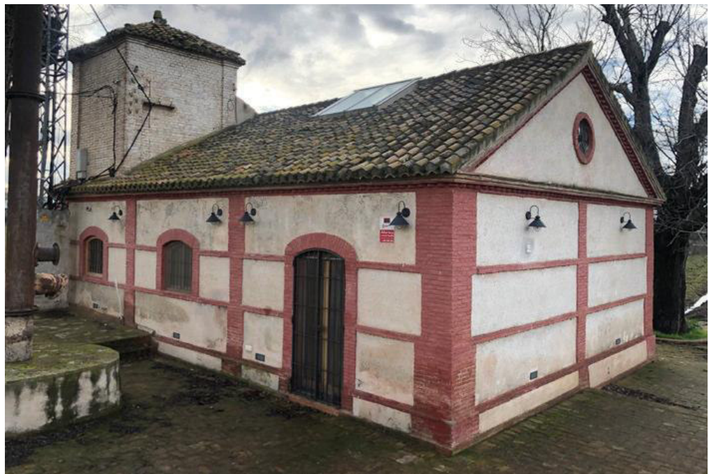
Fotografía del exterior de la edificación
