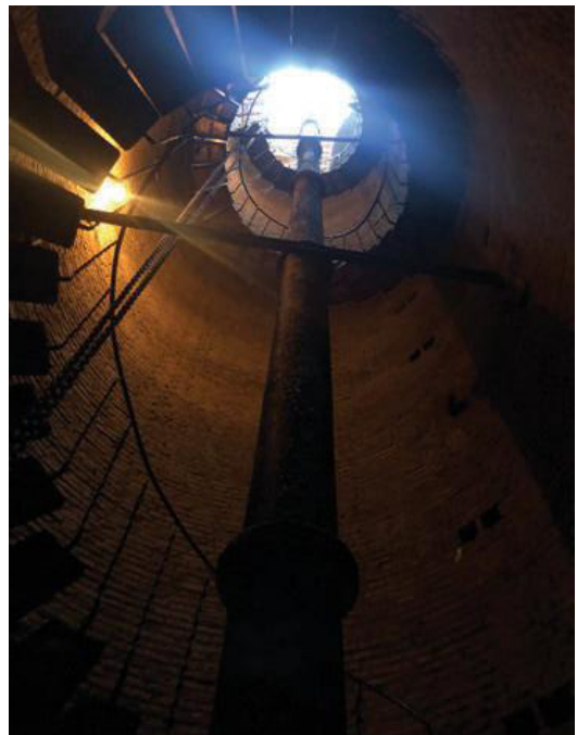
Fotografía interior del pozo desde abajo hacia arriba
