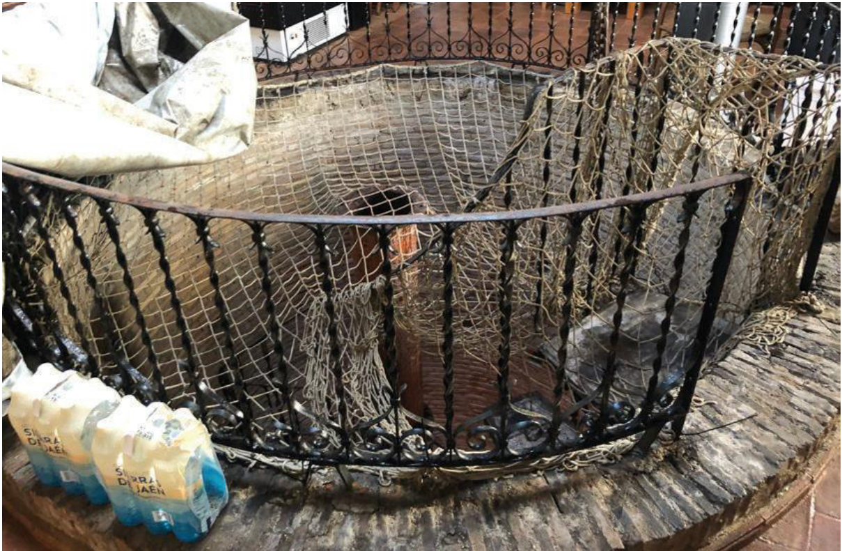
Fotografía del exterior del pozo desde el interior de la edificación
