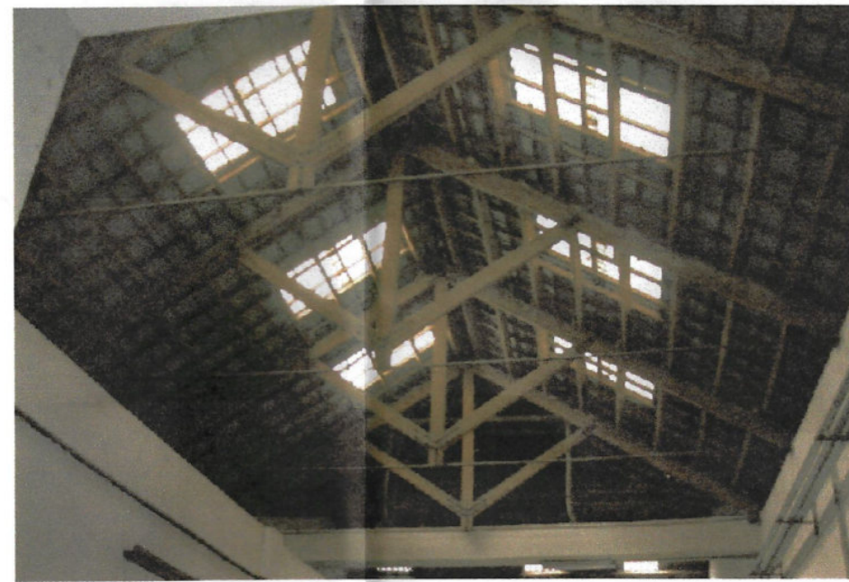
CERCHA PASILLO INTERIOR
