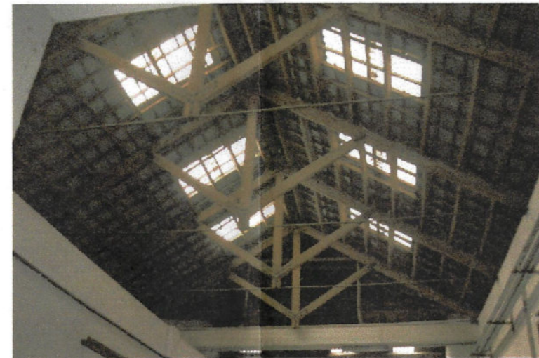
CERCHA PASILLO INTERIOR
