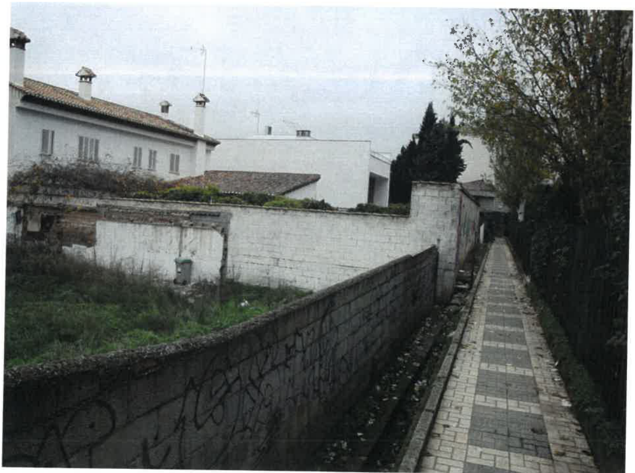
Foto nº 8.- Tramo 1 del “Callejón” (hacia el “Pasaje”)
