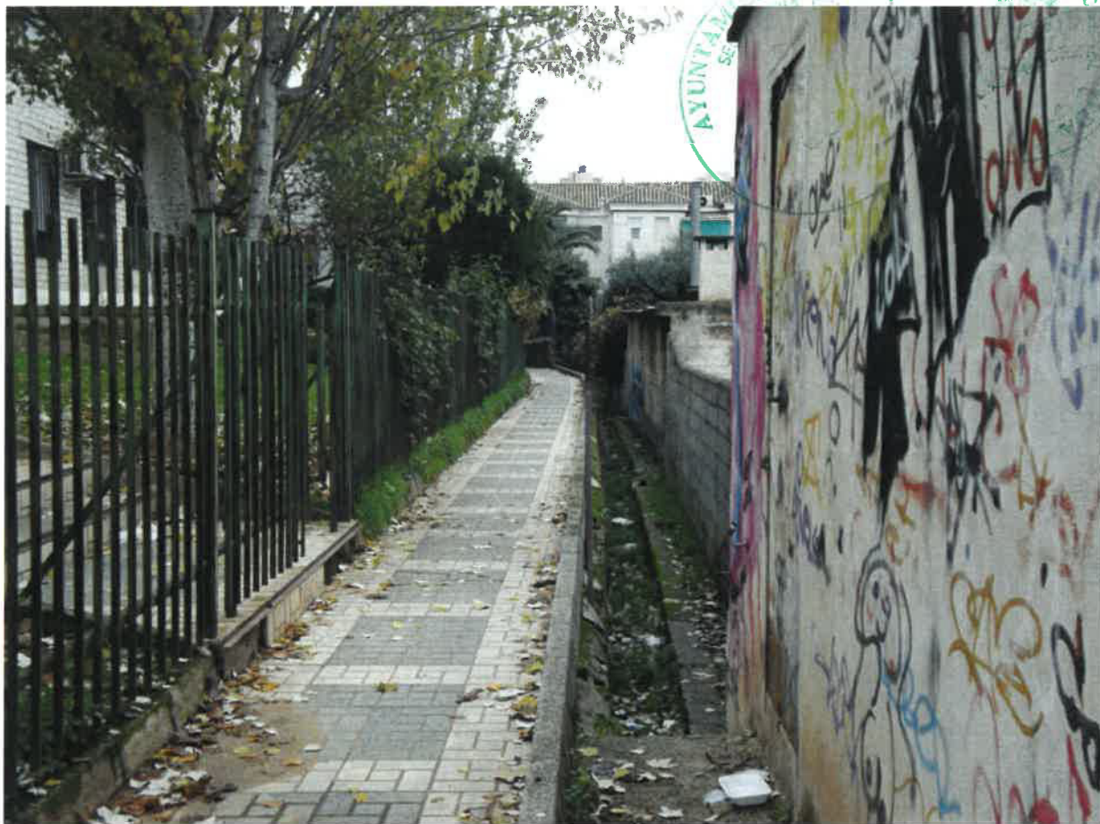
Foto nº 5.- Tramo 1 del "Callejón" (hacia la c/Belén Sárraga)
