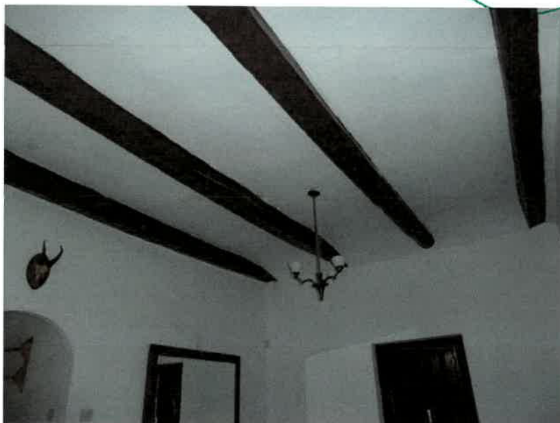
Forjados de madera. Planta primera
