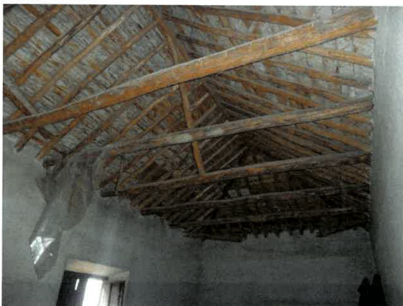
Cubierta de madera almacén planta primera.
