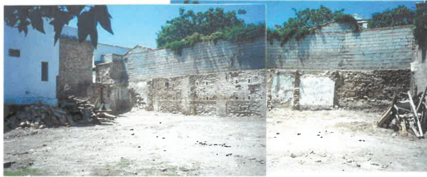
VISTA DE LA PARTE ALTA DE LA PARCELA EN EL AÑO 2001 TRAS LA DEMOLICIÓN DE LAS EDIFICACIONES. LA TAPIA DEL FONDO COLINDA CON LA CASA BOCANEGRA Nº 6
