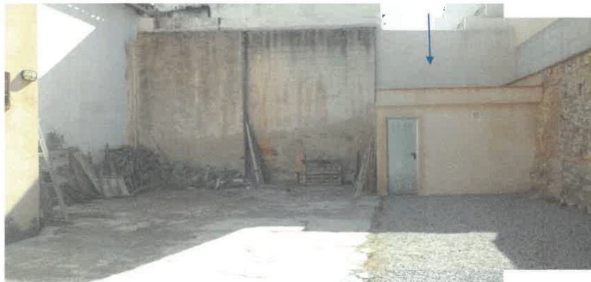
VISTA ACTUAL DEL PATIO POSTERIOR DE LA CASA, CON INDICACIÓN DE LA TAPIA QUE CONSTITUYE LA FACHADA DE LA PARCELA HACIA LA CALLE DE LOS NEGROS
