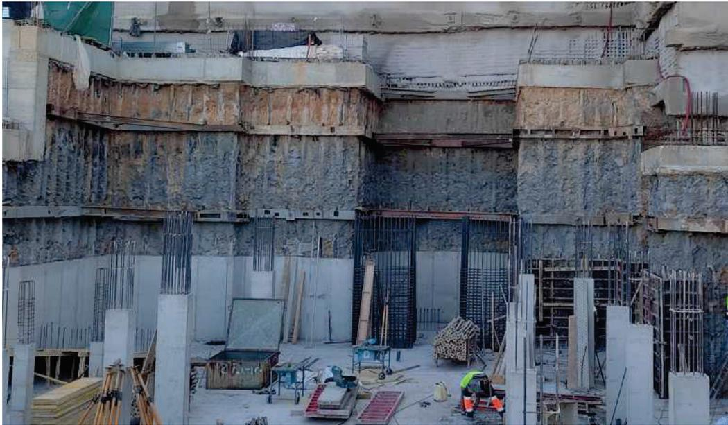
De ahí que se propone corregir la alineación del nivel 0, para hacer que la misma sea coincidente con la alineación del nivel 1 (y resto de niveles), manteniendo su verticalidad, imprescindible para la ejecución en obra del muro de contención de micropilotes:
