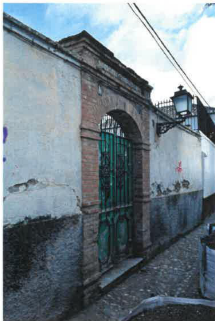
Exterior de acceso
