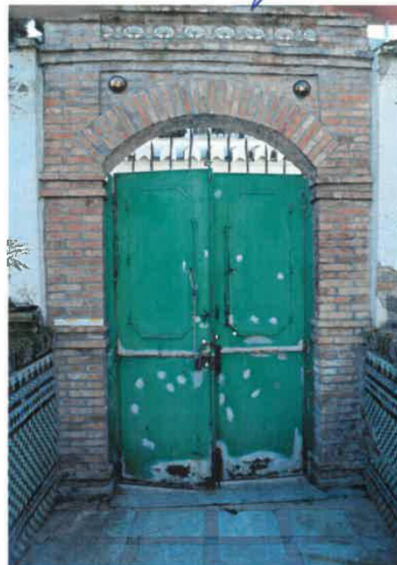
Interior del acceso
