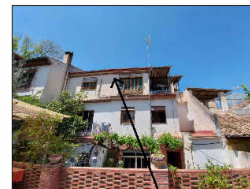
FOTO 6: VISTA GENERAL DEL CUERPO DE EDIFICACION DE TRES PLANTAS CUERPO DE EDIFICACION QUE NO RECOGIA POR ERROR EL PLAN ALBAYZIN
