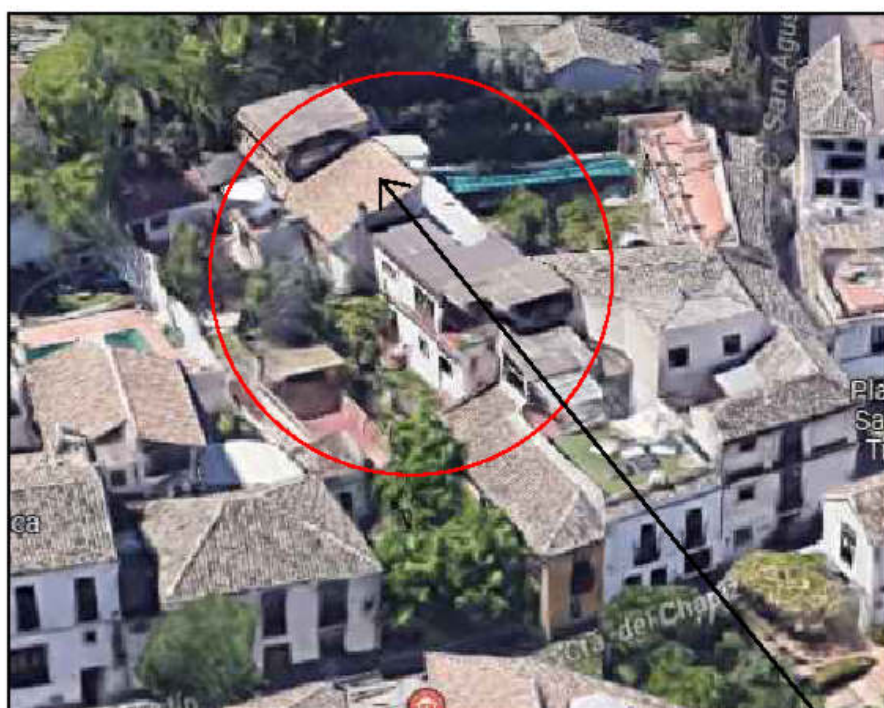
FOTO 4: VISTA GENERAL DEL EDIFICIO. SE PUEDE VER EL JUEGO DE ALTURAS EXISTENTE Y EL EDIFICIO QUE PROYECTA SOMBRA SOBRE EL NUESTRO
