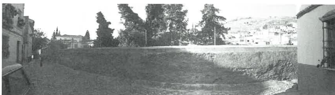
Montaje desde Costanilla de San Agustín (antes Careillo de San Agustín) es más que evidente la continuidad material de todo el muro de cierre, sin divisiones, entradas o cambios de material, lo que evidencia la construcción unitaria y al tiempo. En el interior de la parcela y ya casi no se observa el murete intermedio entre las "parcelas", cuya cualificación como murete de jardín se evidencia en que ni llega de extremo a extremo, ni tiene mas de 1,20 de altura.
