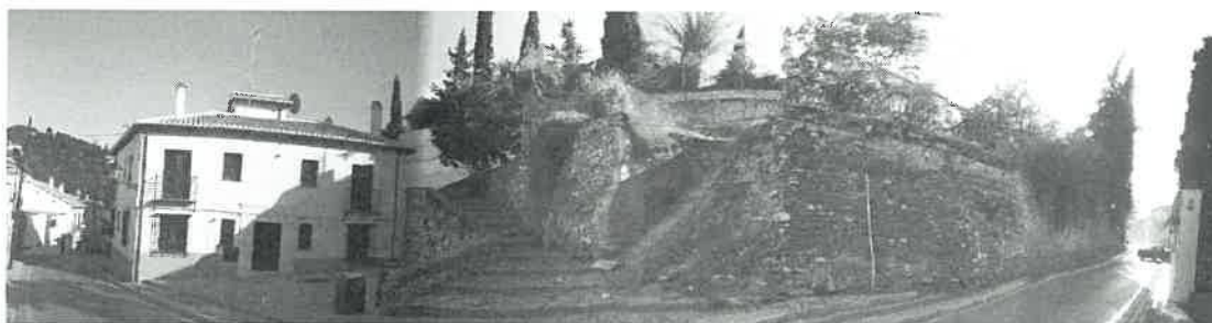
Montaje desde Cuesta del Chapiz. Alzado principal. Nótese la continuidad física del muro de mampostería de contención a Cuesta del Chapiz, amén del espacio liberado en la zona de jardín que las alineaciones del PEPRI albaicín de 1990 proyectan cerrar al incorporar otro volumen en este extremo.
