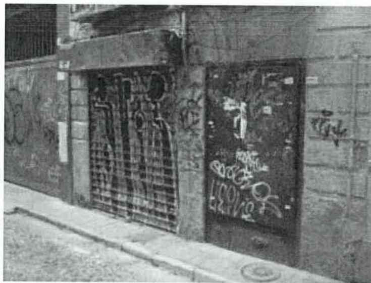
Imagen 02. Detalle fachada planta baja con fecha 2014.
