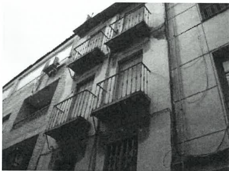
Imagen 01. Vista de la fachada con fecha 2014.
