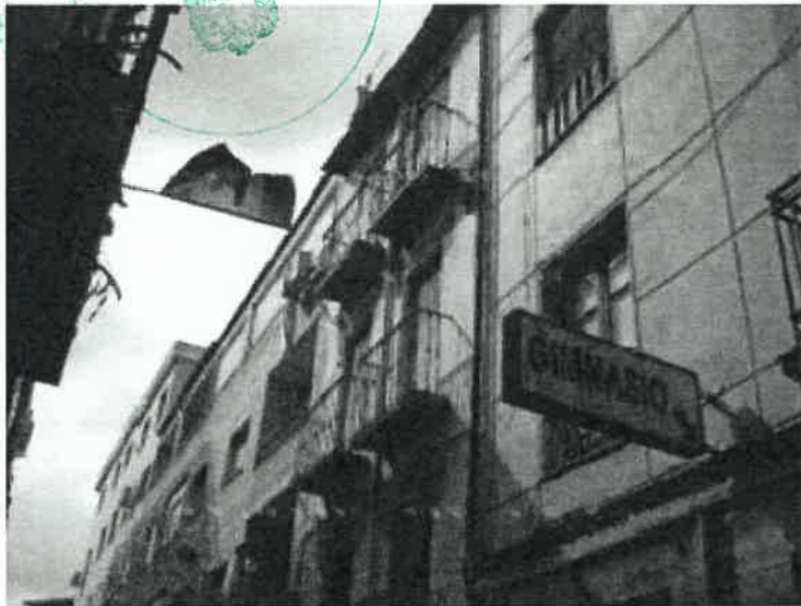
Imagen 03. Vista de la fachada con fecha 2014.
