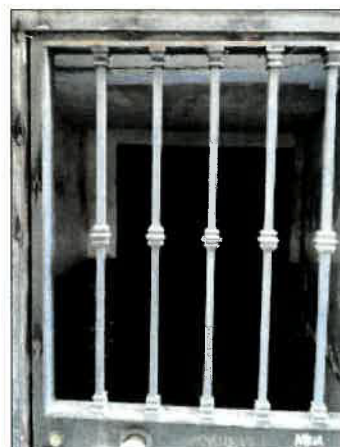
Detalle cerrajería en fachada
