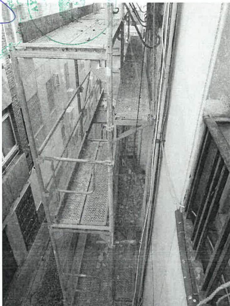
Imagen 12. Escombros sobre andamio. Diciembre 2018
