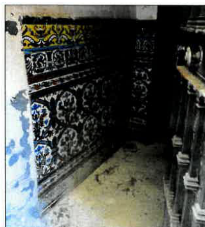
Detalle alicatado en zaguán
