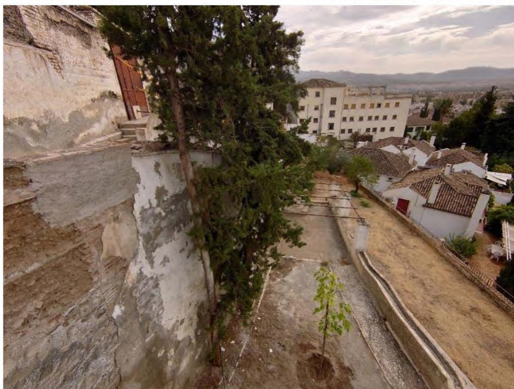
VISTAS DEL INTERIOR DE LA PARCELA
