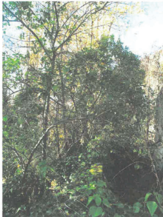
Foto 8.- Muro de cerramiento desde la parte superior, con los arboles adosados al exterior de la linde.
