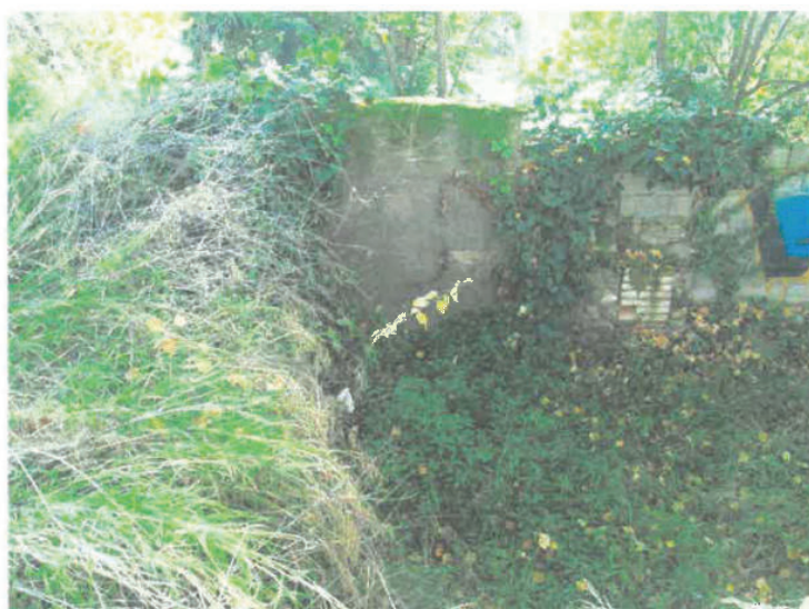
Foto 4.- Pared medianera de la parte interior de la parcela, donde se ubicaba la nave de carpintería.
