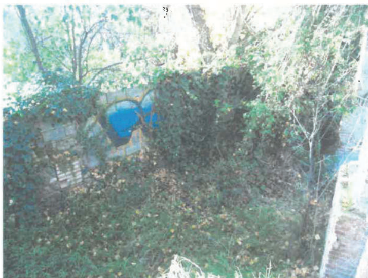
Foto 5.- Vista desde arriba, del muro de cerramiento de la parcela hasta llegar a la estructura del acueducto sobre el que discurre la acequia.
