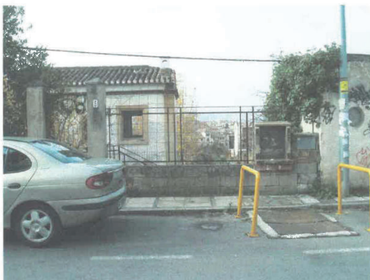
Foto 1.- Fachada de la vivienda nº 6 de la C/ Paseo de las Palmas
