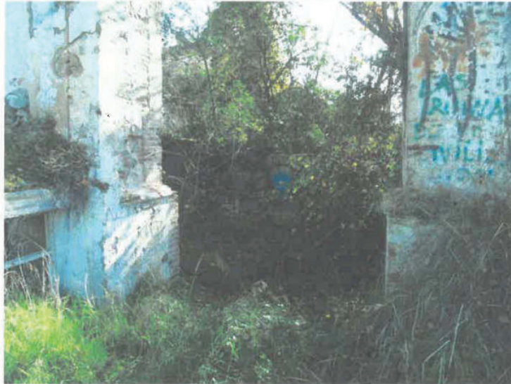
Foto 7.- Vista desde el otro lado del acueducto, quedando el cerramiento de la parcela al fondo.
