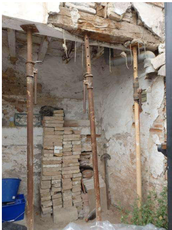
Fig. 20. Pórtico de fachada apuntalado. (Fotografía de la autora)
