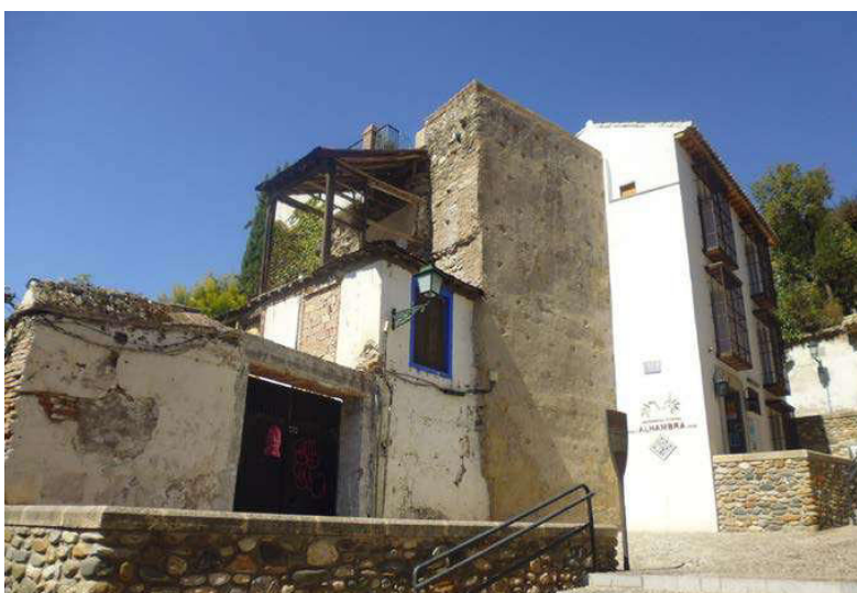
Fig. 2. Imagen general de la torre zirí flanqueada por los edificios de la placeta de las Escuelas nº1 a la izquierda y nº2 a la derecha. (Fotografía de la autora).
