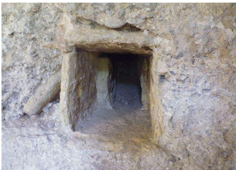
Fig. 22. Sistema de desagüe de la muralla. (Fotografía de la autora).
