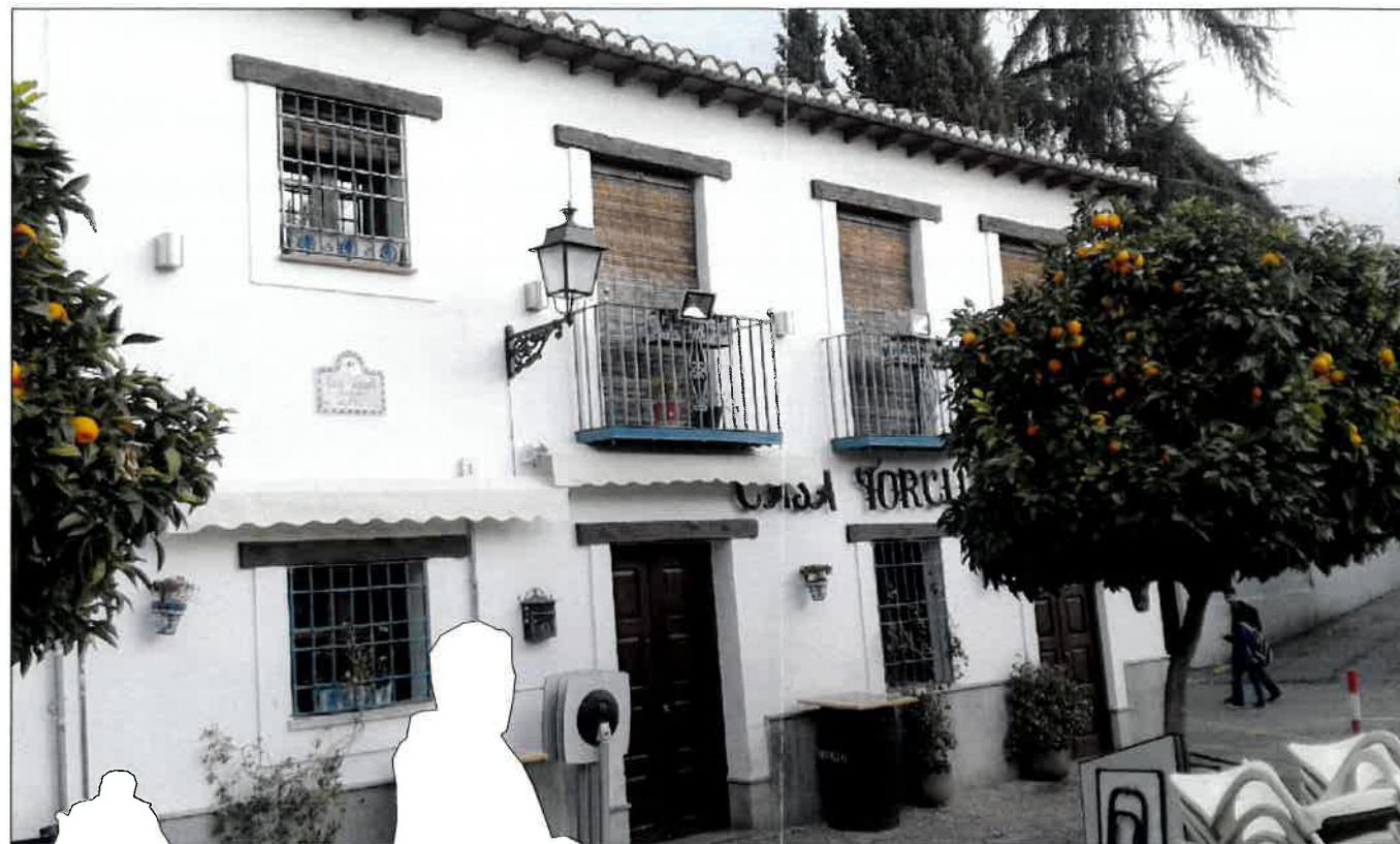
Fotografía F1 Fachada de la Vivienda 1 hacia la Placeta de Carniceros.
