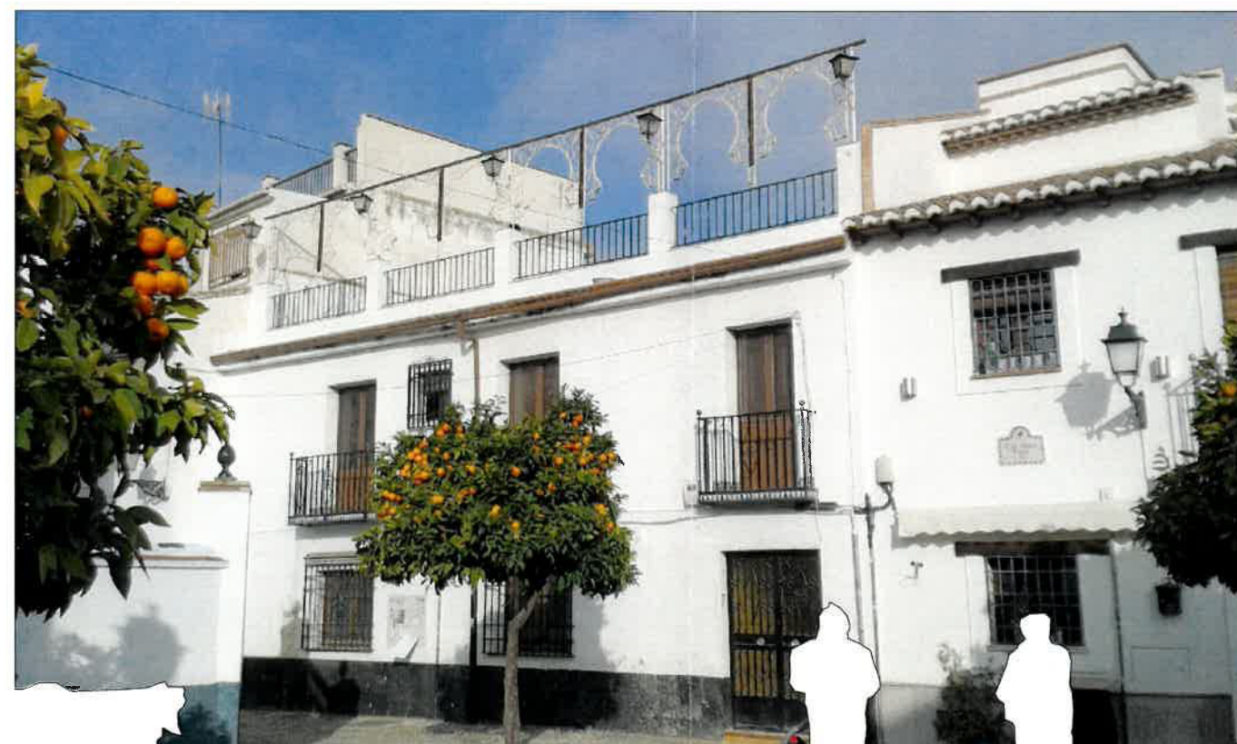
Fotografía F2 Fachada de la Vivienda 2 hacia la Placeta de Carniceros.
