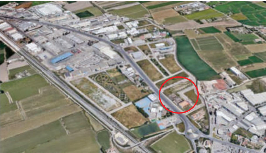
Figura 7. Visión aérea de la zona de actuación.
