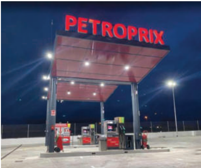
Figura 10. Gasolinera de dos marquesinas en Leganés
