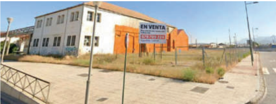
Figura 3. Vista general de la parcela desde el vial auxiliar a Carretera N-432.
