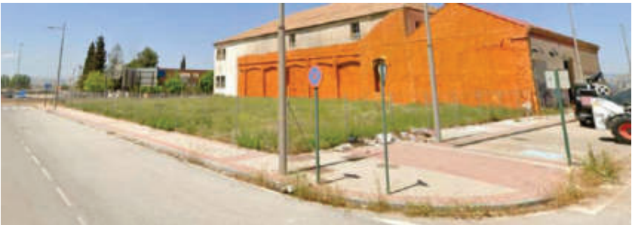
Figura 4. Fachada desde intersección de viales.
