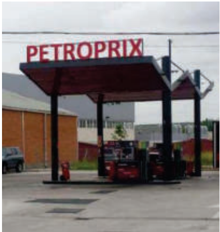
Figura 9. Gasolinera de dos marquesinas en Mejorada del Campo
