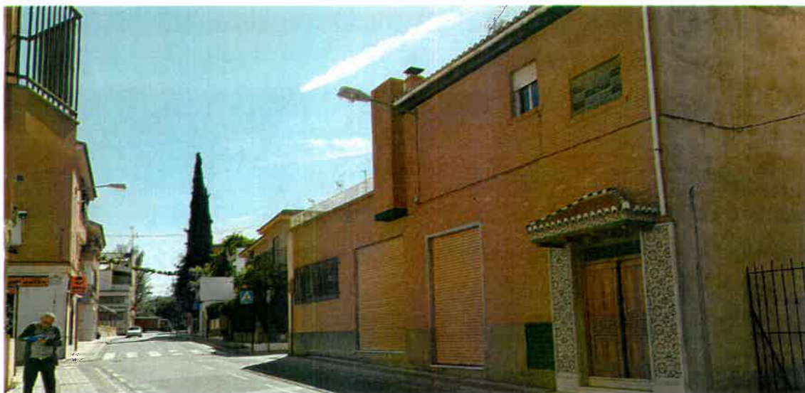
Imagen 02.-Imagen de la edificación existente a C/Carlos Fuente: Elaboración Propia
