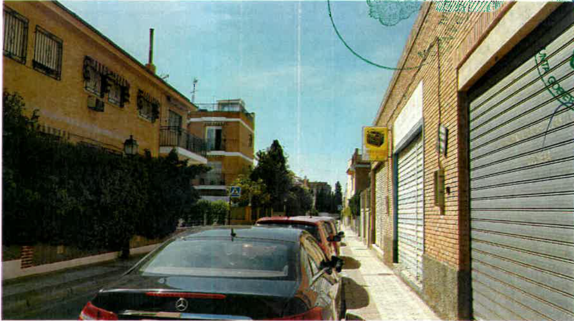
Imagen 02.-Imagen de la edificación existente a C/Álvarez Pelayo Fuente: Elaboración Propia
