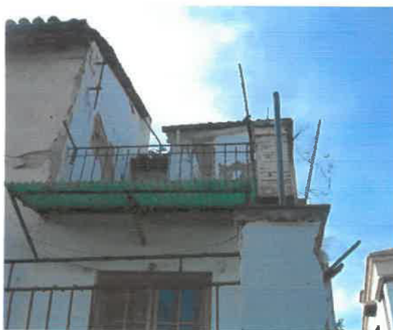
Imagen 3. Vista de azotea desde el patio previa a las obras de conservación
