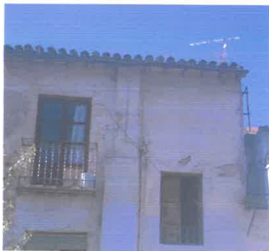
Imagen 2. Vista fachada al patio previa a las obras de conservación
