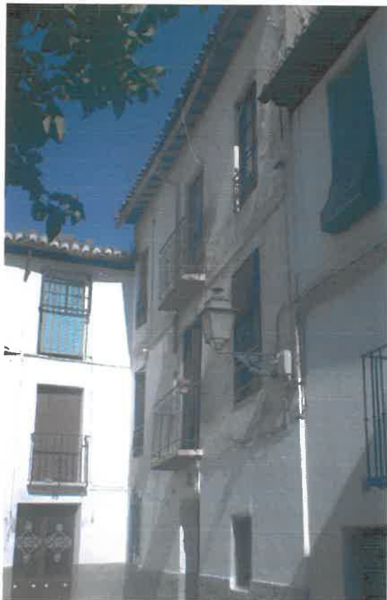
Imagen 1. Vista fachada a C/ Tiña previa a las obras de conservación
