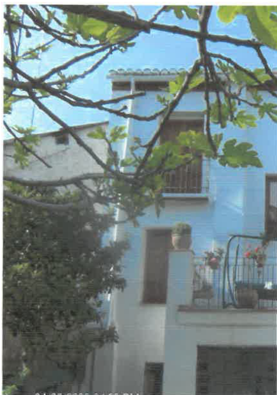
Imagen 9. Vista fachada al patio
