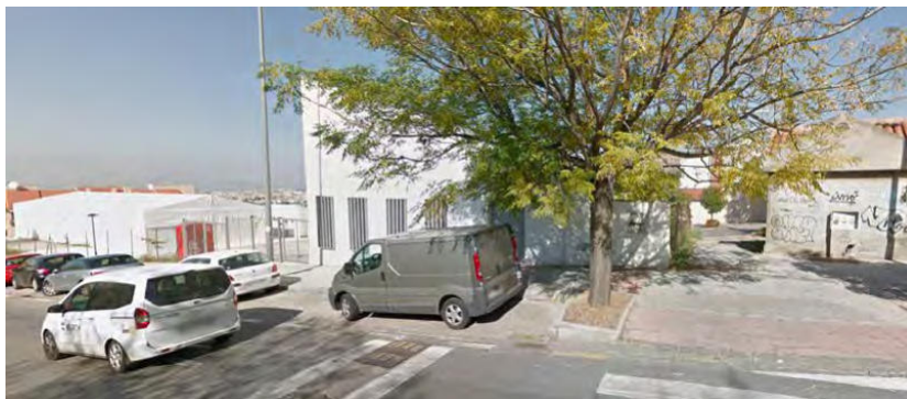
Construcciones en solar del CONJUNTO URBANO E6 propiedad del Arzobispado: a la derecha, CT de la urbanización; en primer plano, Capilla con licencia provisional; a la izquierda carpa de uso religioso con licencia provisional (foto octubre de 2019).
