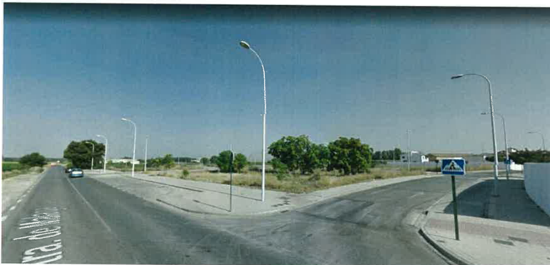
Imagen 4. Vista a pie. Intersección de Ctra. de Málaga y Calle Secaderos.
