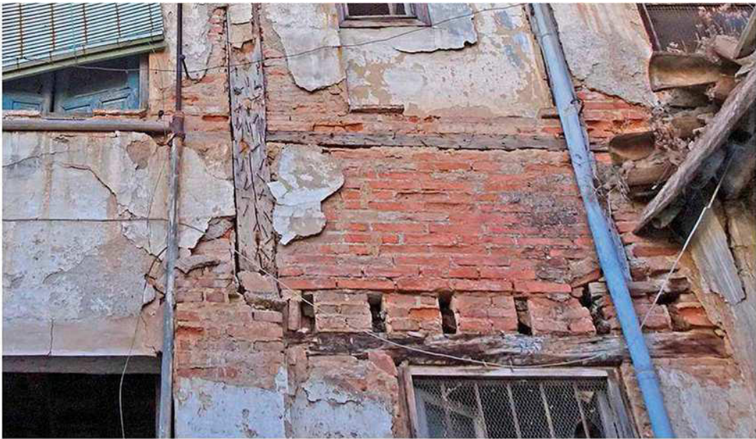
14.- Cuerpo oriental, detalle vigas de madera y fabricas con ladrillos industriales
