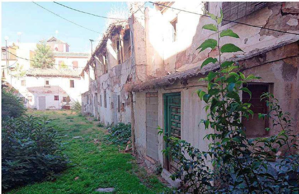
19.- Desde entrada central, acceso al patio
