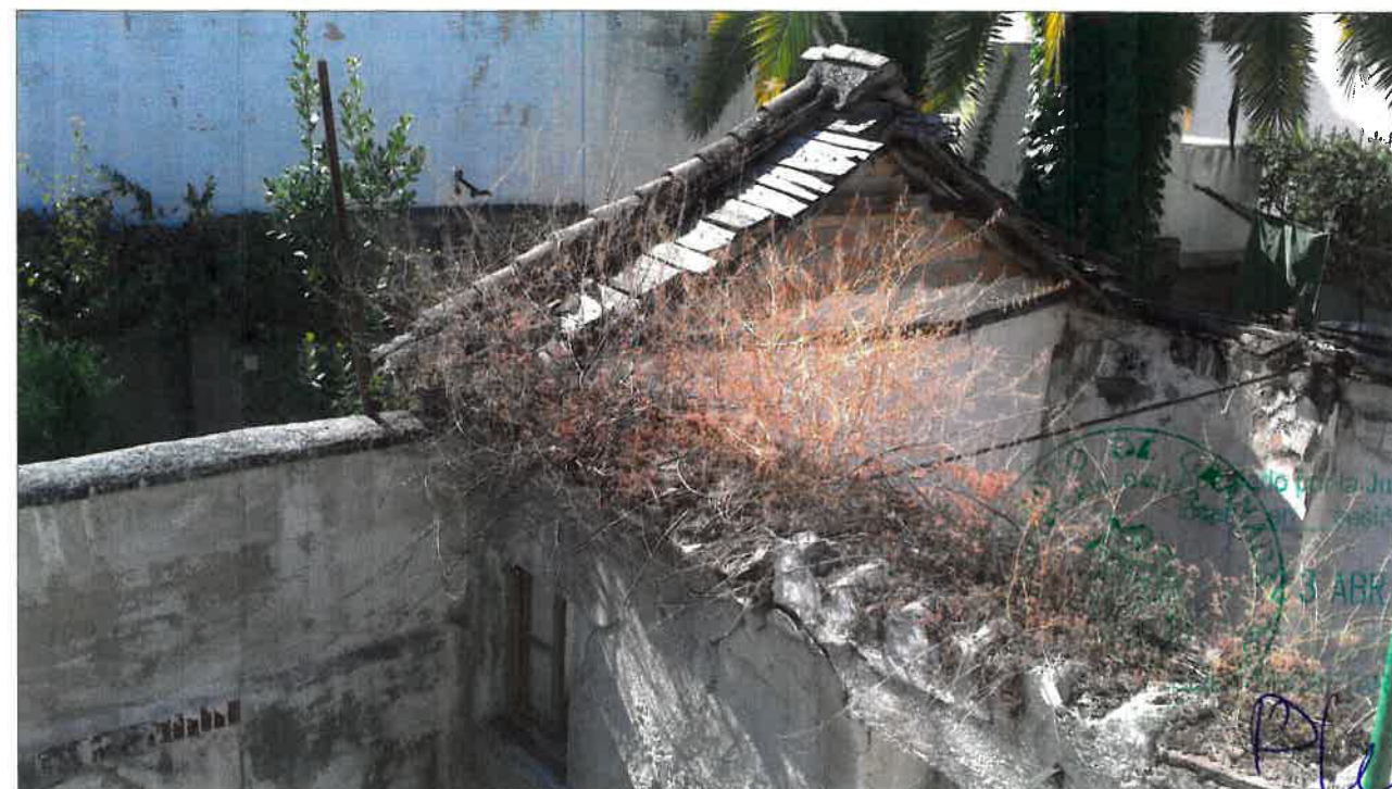
Fotografía F2 Imagen del resto de la cubierta.
