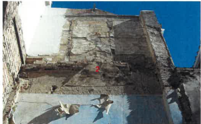
VISTA ACTUAL DE LA MEDIANERA 2 CON RESTOS DE REVOCO DE CONSTRUCCIONES ANTERIORES POR ENCIMA DE LA ALTURA DE LA EDIFICACIÓN EXISTENTE ANTES DE LA DEMOLICIÓN PARCIAL
