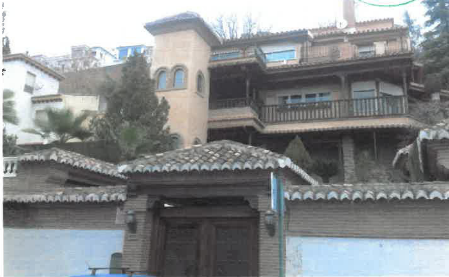
PASEO DE LAS PALMAS N° 21 (TORRE VISTA DE ASCENSOR)
