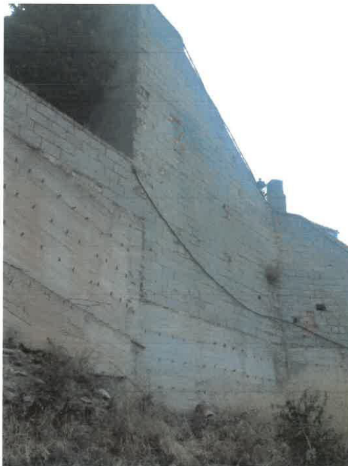
MURO DE CONTENCIÓN POSTERIOR, DE 11 m DE ALTURA
