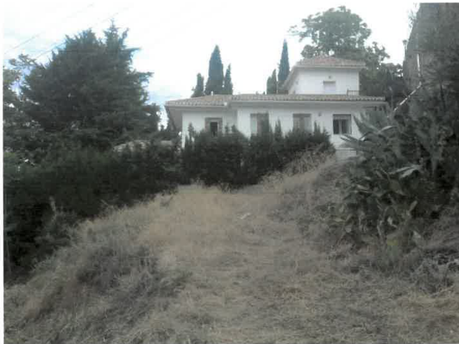
EDIFICACIÓN DE LA PARCELA COLINDANTE
