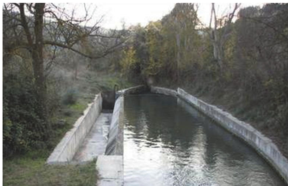
Acequia Real. Toma el agua en la Presa Real y avanza en paralelo al curso del río Darro, por su margen derecha, por la ladera Norte del Cerro del Sol. Es el elemento esencial del sistema hidráulico de la ciudad palatina de la Alhambra.
