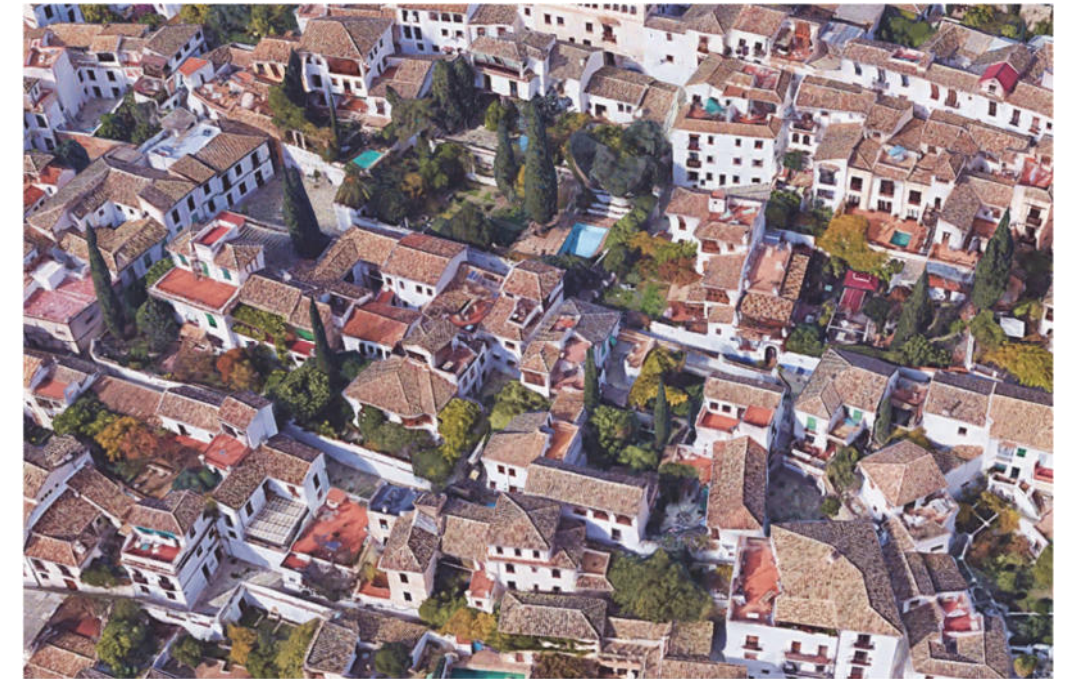
La casa-jardín o carmen granadino es un tipo de edificación que constituye un elemento de singular importancia en la infraestructura verde urbana de la ciudad de Granada.
