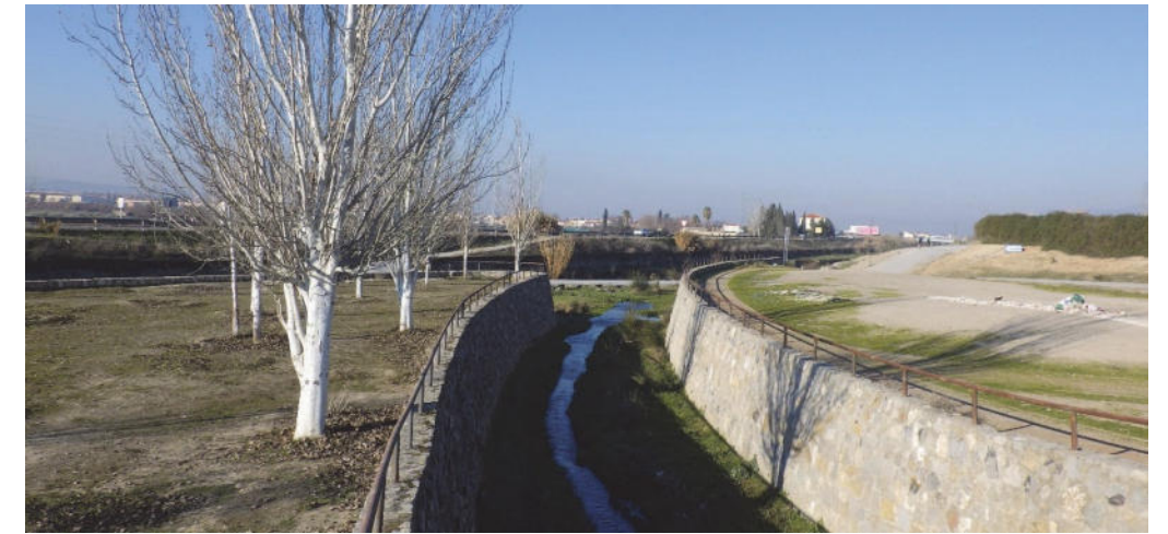
El río Beiro encauzado, delimitado por superficies artificiales que disminuyen sus servicios ecosistémicos, destacando su necesidad de renaturalización y restauración.
