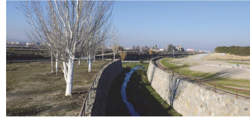
El río Beiro encauzado, delimitado por superficies artificiales que disminuyen sus servicios ecosistémicos, destacando su necesidad de renaturalización y restauración.
